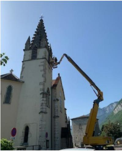
Intervention sur le clocher de l'église afin de remplacer des morceaux de tuf et de mortier éclatés par le gel
