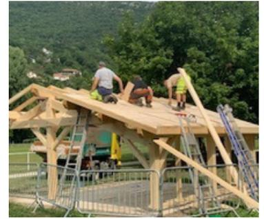
Au stade, suivant le projet de l'atelier participatif, montage par nos services techniques d'un abri multi activités; réalisation d'une dalle béton, puis montage d'une structure bois fabriquée par la scierie Eymard, couverture en tuiles suivant avis de l'architecte des bâtiments de France, l'abri étant en covisibilité de la tour.
