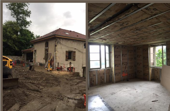
**La Cure:** le bâtiment est clos et les réseaux VRD en place. A l'intérieur, pose de l'isolation, cloisons, électricité, plomberie etc.
